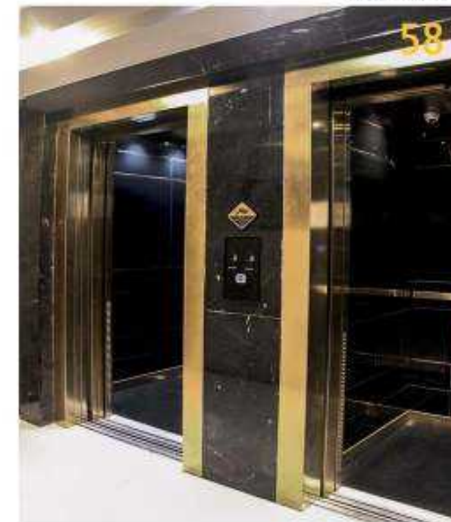
57-58 نام پروژه: مجتمع اداری دانا سرمایه کارفرما: رضا صادقی نوع آسانسور: کششی سال ساخت: ۱۳۹۷ تعداد: ۲ دستگاه
